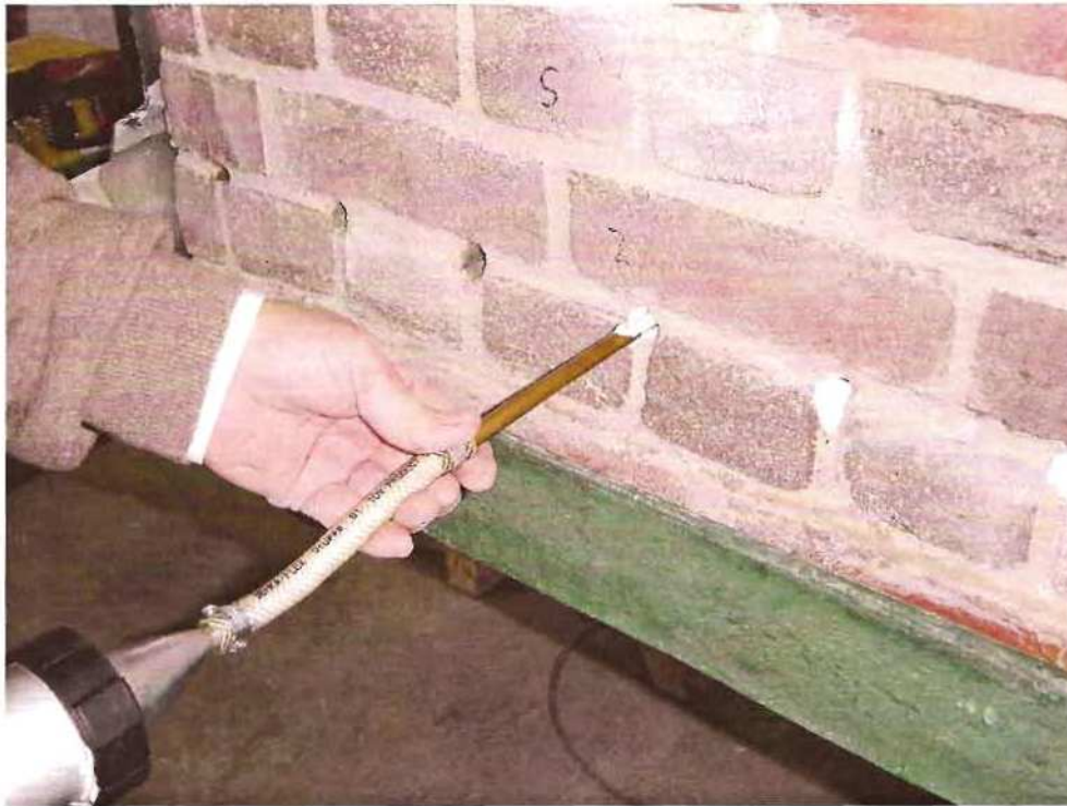
Fot. 3: Wstrzykiwanie środka DRYZONE .
