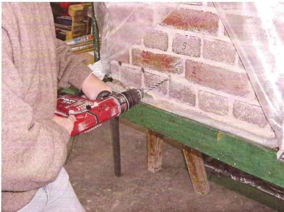
Fot. 2: Wiercenie otworów iniekcyjnych.
